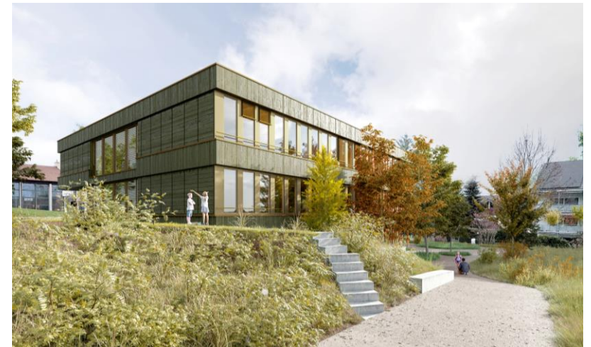
Ansicht vom Hasenweg auf die obere Ebene
