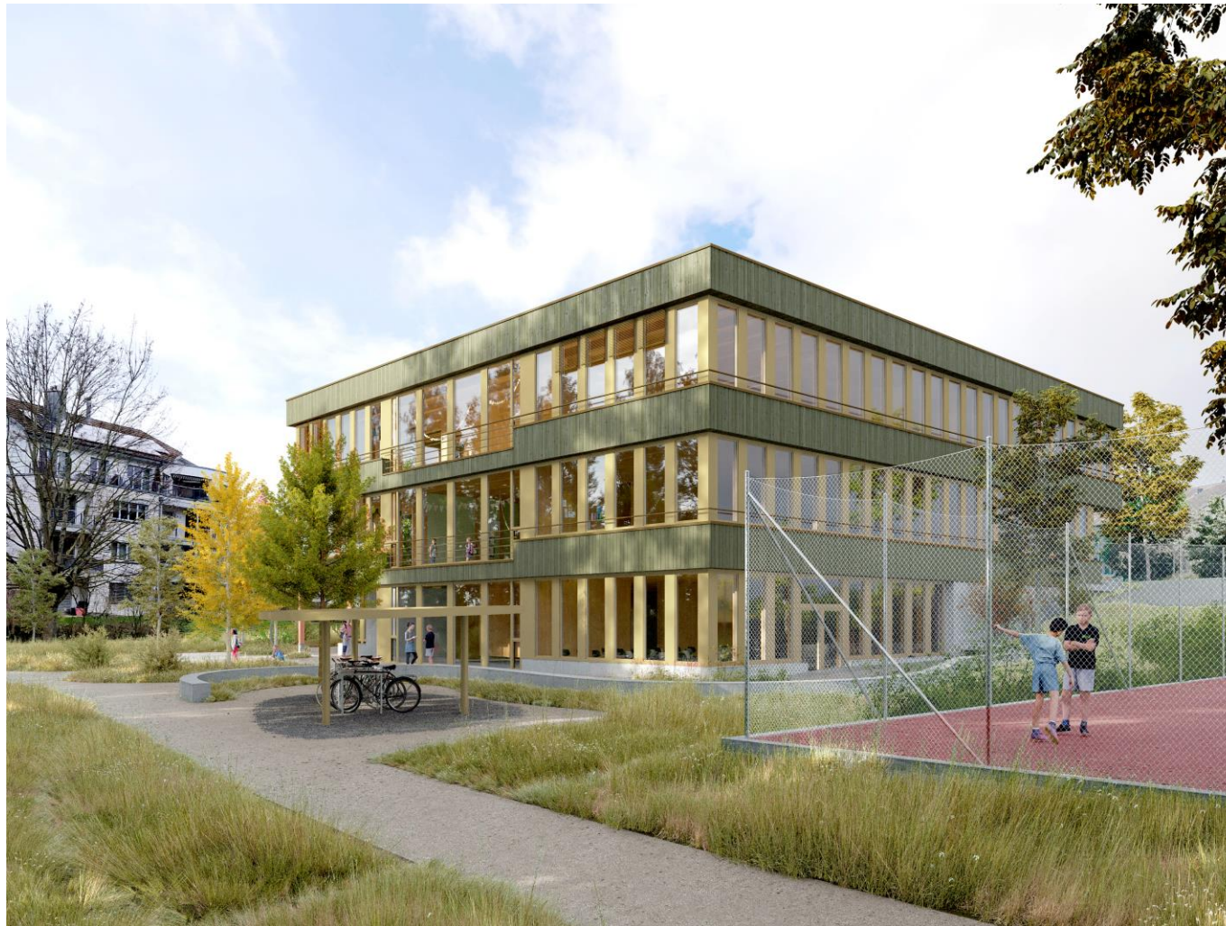
Ansicht Haupteingang Norden
